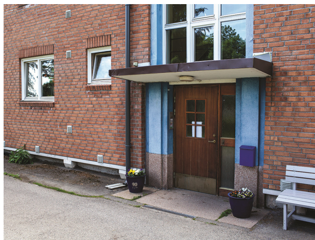
Eksempel på etterisolering med utvendig isolasjon og murt forblending. Foto: SINTEF Byggforsk
