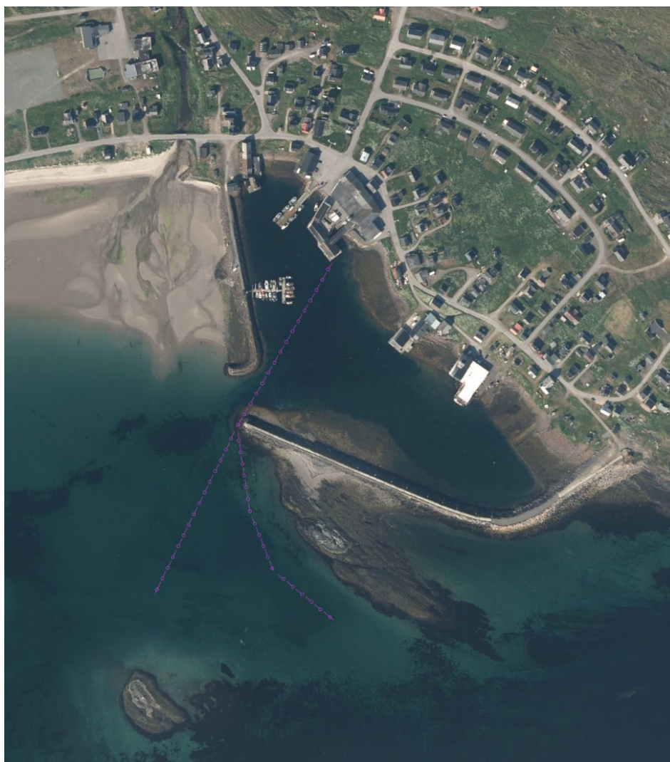
Figur 5 Sjøvannsledning med inntak, Kiberg Havn.
