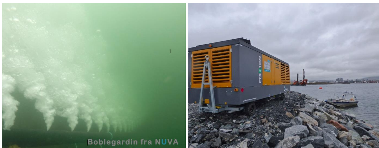
Figur 17: Boblegardin installert av NUVA i Indre Oslofjord. Til venstre: Luftdyser på havbunn. Til høyre: Kompressor som leverer luft. [16].
